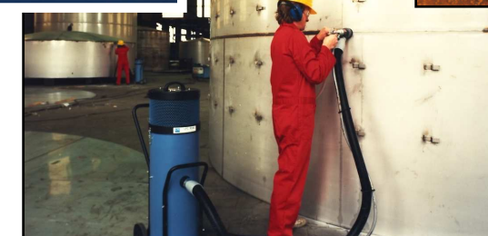
Het stralen van stalen en RVS lasnaden
